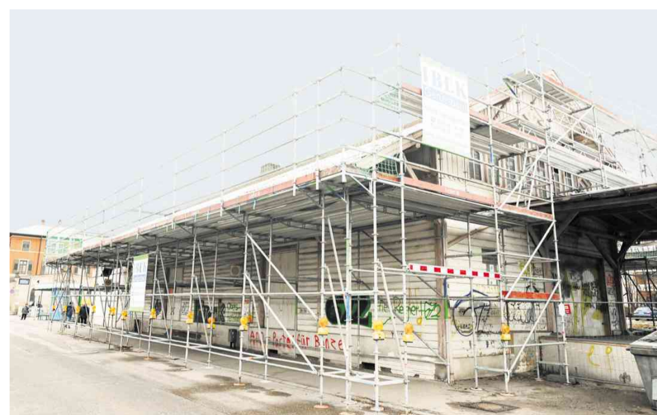
Der Schuppen wird saniert. Unklar ist, was danach mit dem Gebäude passiert. Foto: Werner Kuhnle
