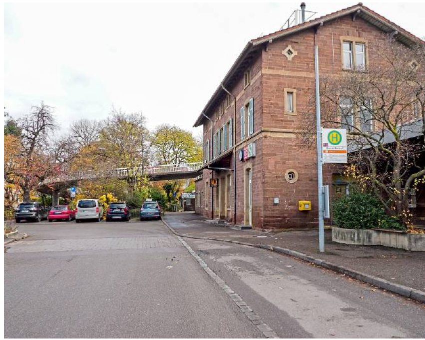
Wo derzeit Parkplätze sind, soll sich nächstes Jahr viel verändern, ebenso am Bushalt. Insgesamt ist aber auch mehr Grün geplant. Archivfotos: wo/Faktor Grün
