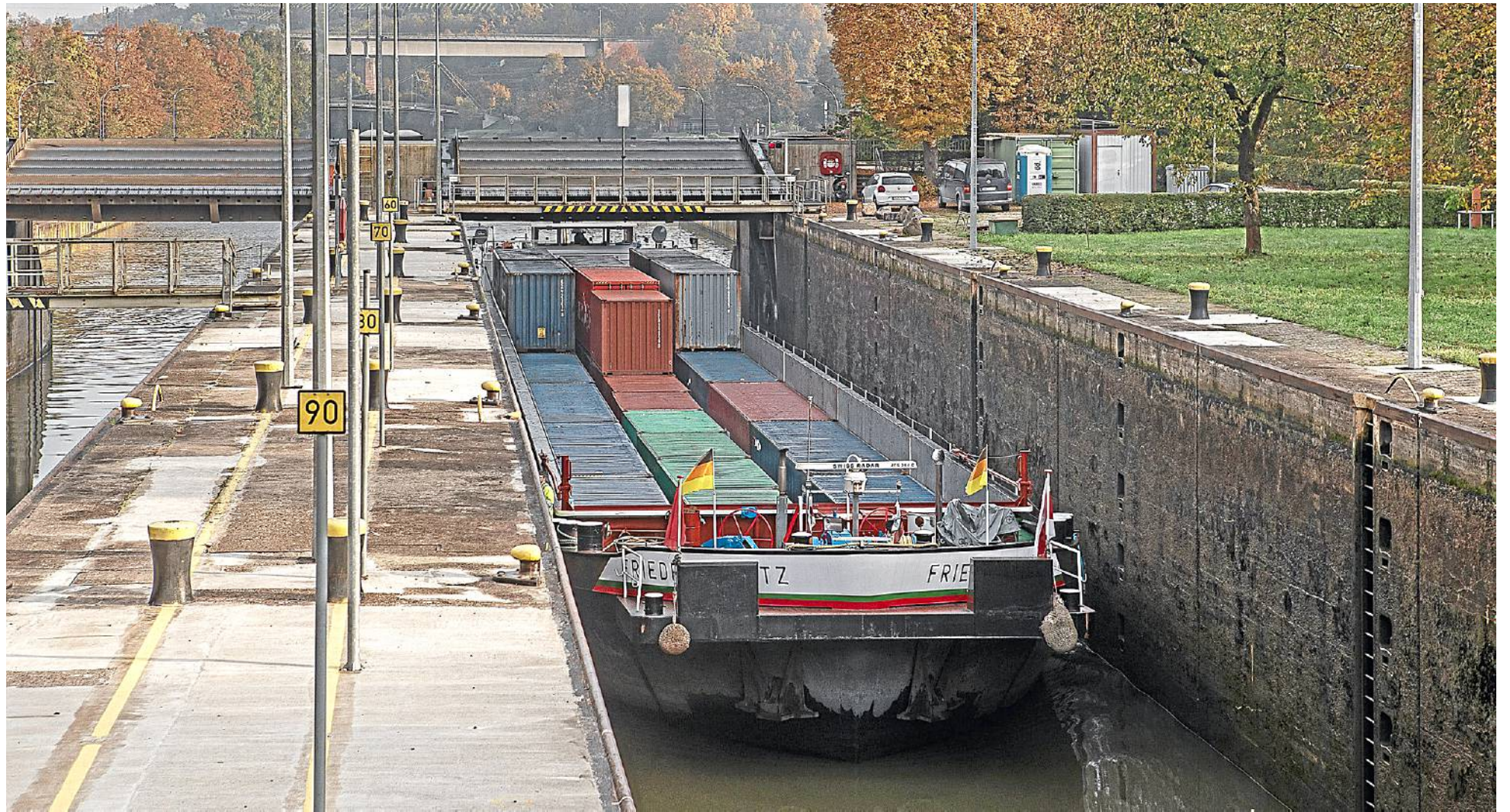
Zu kurz und sanierungsbedürftig: Ein heftiger Streit ist über die Verlängerung der Neckarschleusen entbrannt.
