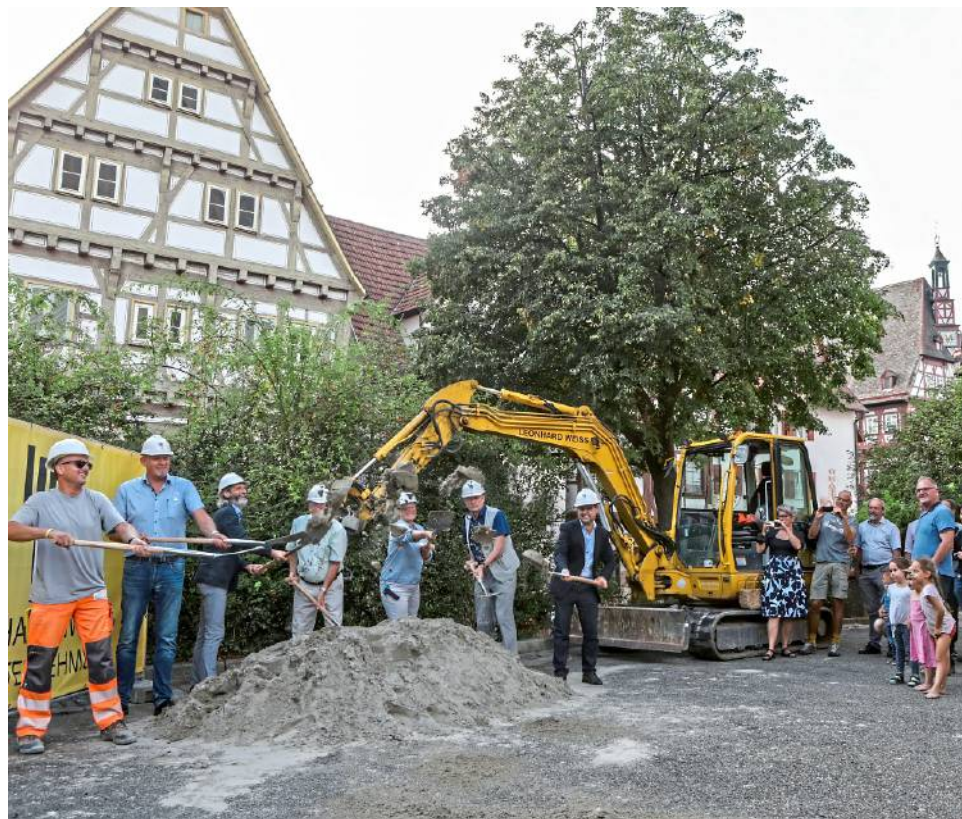
Der Markgröninger Kirchplatz bekommt zum 750. Geburtstag der Bartholomäuskirche ein neues Gesicht. Der symbolische Spatenstich ist bereits geschafft. Foto: Ramona Theiss
