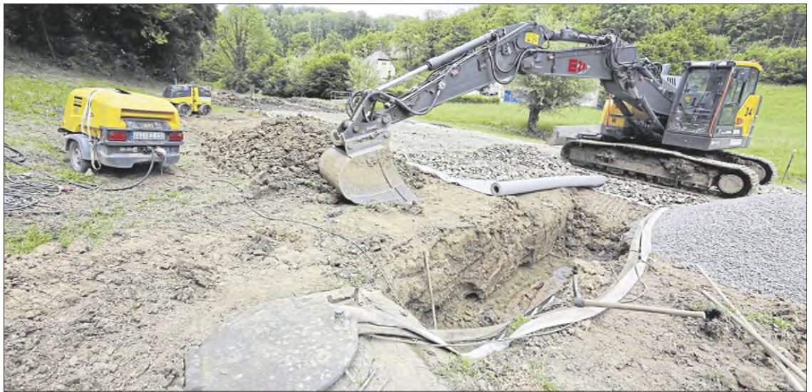
Die Quellfassung (vorne) wird ebenso erneuert wie die Ablaufleitung in Richtung Eberdingen. Die Bauarbeiten im Strudelbachtal haben begonnen und sollen bis Herbst dauern.
