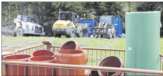
Baumaschinen warten auf ihren Einsatz im Strudelbachtal.
